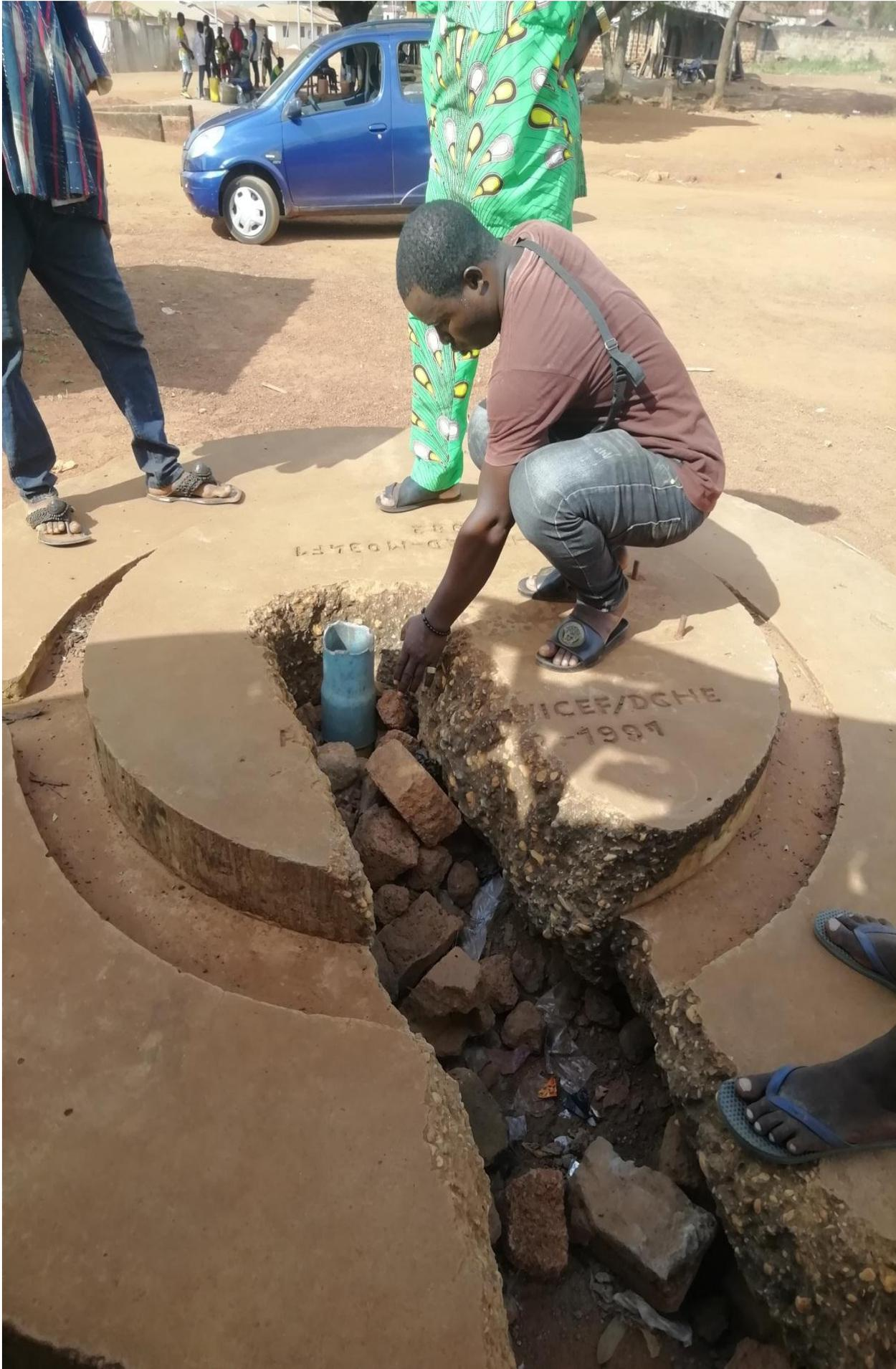
Un exemple de forage du projet musulman installé en 2020 qui ne fonctionne pas.
